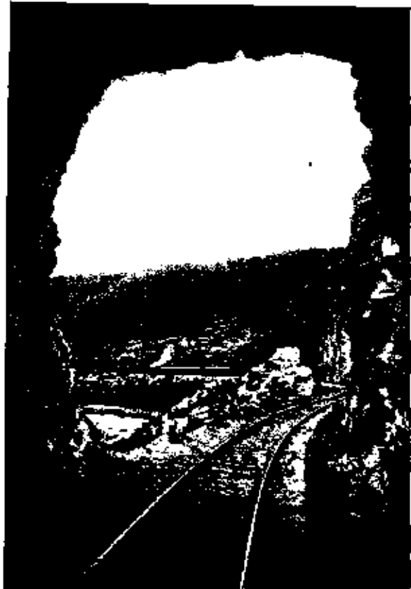
Túnel o abertura que se practica a través de una montaña para dar paso a un ferrocarril.
