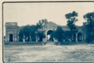
Tipo de casa de empleados del ingenio «San Andrés».
